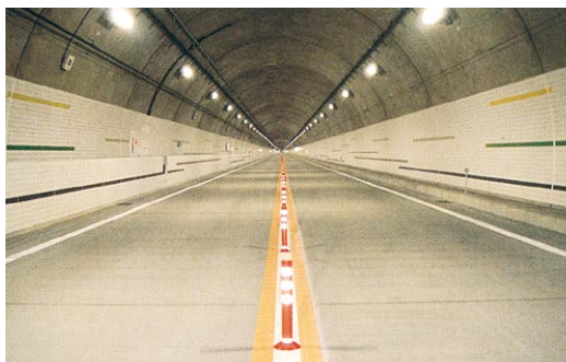
中部縦貫自動車道「小鳥トンネル」
