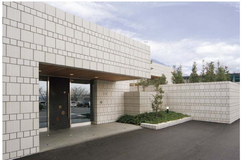
施工 株式会社土本建設
