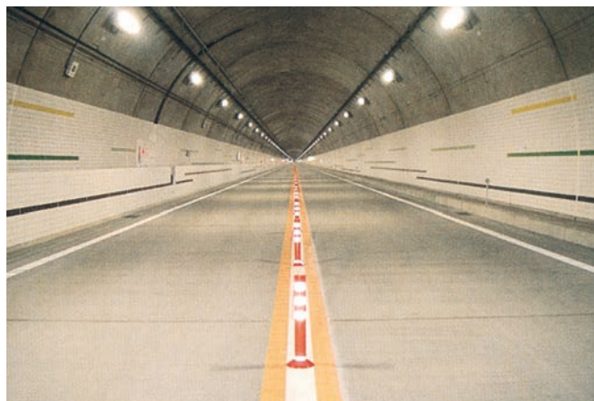
中部縦貫自動車道「小鳥トンネル」
