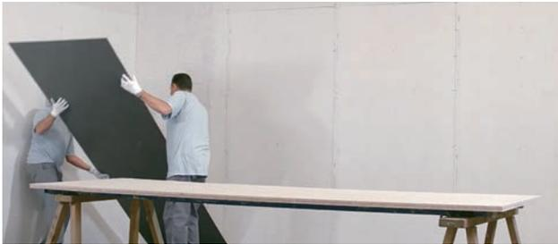
タイルを張ります。ウルトラライトのオープンタイムは夏場の天候気温で30分です。接着剤の表面に薄膜ができた場合はクシ目コテで再度接着剤を塗布します。**※薄膜がある場合、接着剤の表面を水で濡らさないでください。**水は薄膜を溶解しないため、接着不良の原因となります。また、直射日光、乾燥風、高温など通常の条件でない場合や、下地に吸収性がある場合はオープンタイムが数分になってしまう場合があります。
