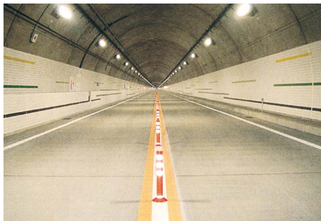
中部縦貫自動車道「小鳥トンネル」
