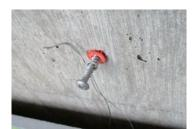
③ステン線を用いた場合は、リベットから伸びているステン線をビスに巻きつけます。 ※ステン線を巻きやすいようにビスは予め長めに出しておきます。
