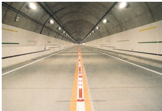
中部縦貫自動車道「小鳥トンネル」
